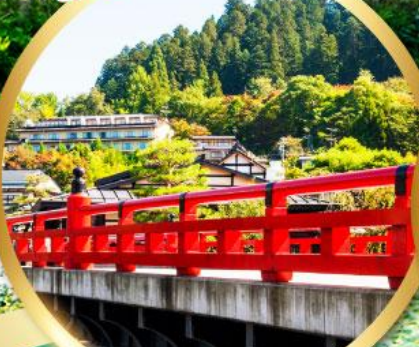
สะพานนากะบาชิ
